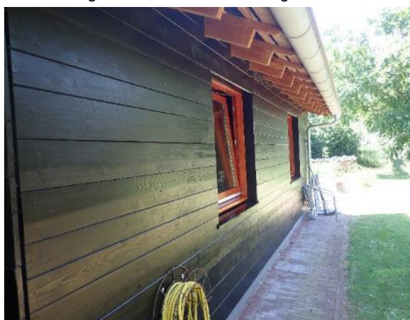
Foto 3.8.6 gevel in de schaduw staat er nog goed bij.
