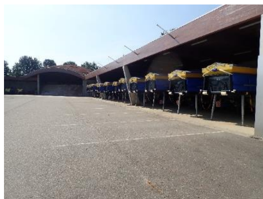
Foto 3.3.2: Overzicht een van de drie zijden en een hoek (links in de foto) van de zoutloods.
