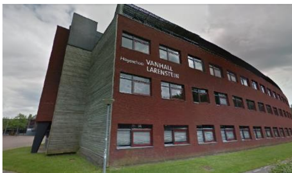
Foto 3.2.1: Gevelaanzicht vanaf de toegangsweg. Bron: Google maps.
