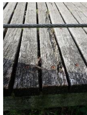
Foto 3.9.15 Dek aantasting / verwerking in relatie tot houtkwaliteit.
