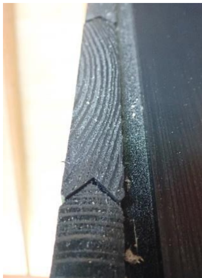
Foto 3.8.3 bijzondere messing-groef V-verbinding.
