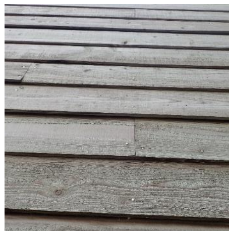
Foto 3.2.4: Gevelbekleding gemonteerd met één nagel.
