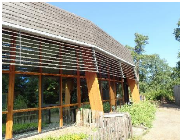
Foto 3.6.2 Spanten lopen uit het gebouw.
