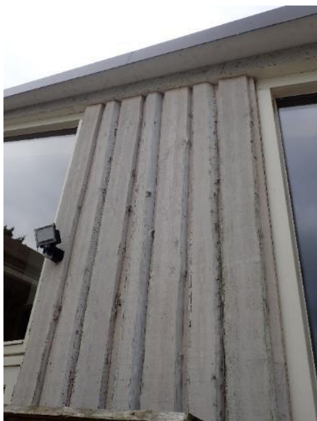
Foto 3.7.4 De gevelbekleding bestaat deels uit larsen schaaldelen.
