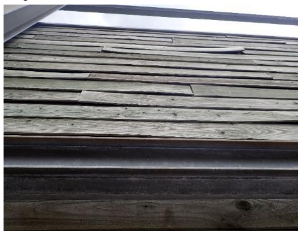
Foto 3.2.6: Gevelbekleding (zuidzijde), onsamenhangend door grote vervorming.
