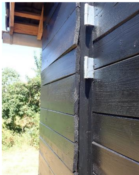
Foto 3.8.4 geveldelen door zon kromgetrokken.
