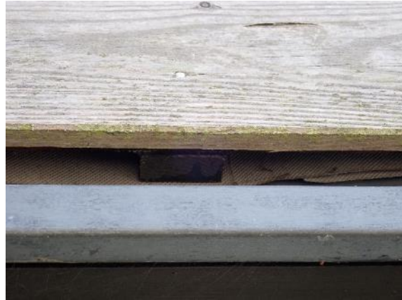
Foto 3.1.4: Enkel regelwerk toegepast.
