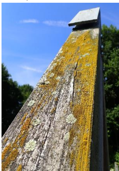
Foto 3.9.7 Draagconstructie mos aangroei door afwatering.
