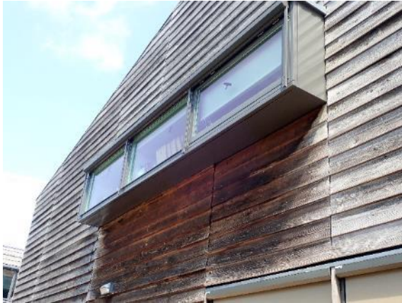
Foto 3.1.3: Geen egale vergrijzing ten gevolge van uitstekende kozijnen.
