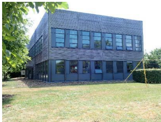
Foto 3.1.2: Gevelaanzicht (zijgevel) huidige situatie.
