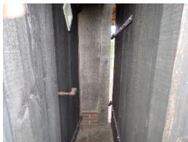
Foto 3.11.8 Voorzijde naast poort.
