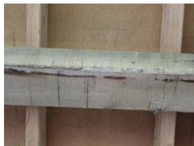
Foto 3.11.9 Actieve gewone houtworm in hardboard.
