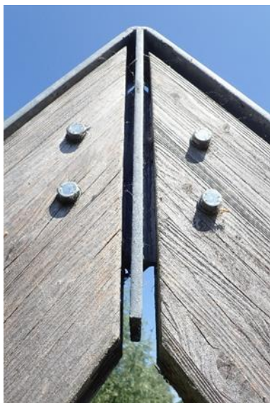
Foto 3.9.4 Draagconstructie detail bovenzijde.
