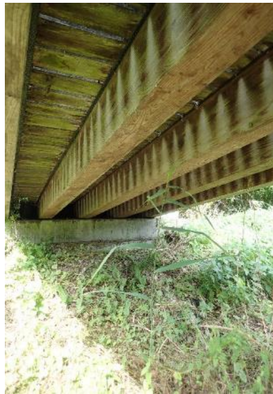
Foto 3.9.2 Onderzijde brug met liggers.
