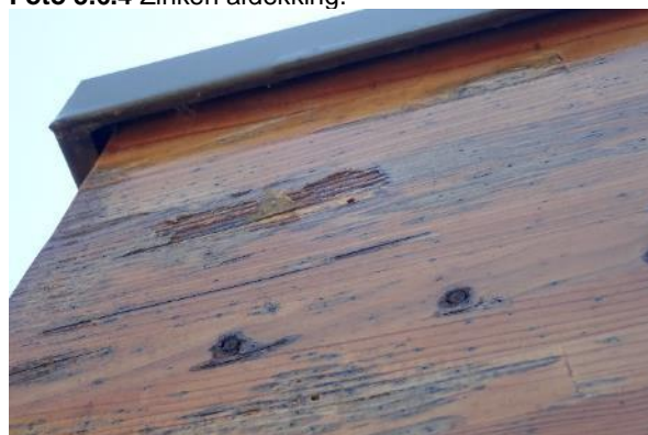
Foto 3.6.6 Afbladdering van de transparante afwerking.
