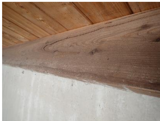
Foto 3.3.8 Jaarring-scheuren in een van de gordingen.
