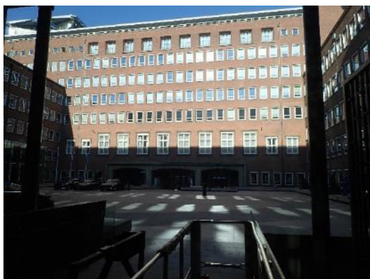
Foto 3.5.3 Meest noordelijke binnenplaatsgevel.
