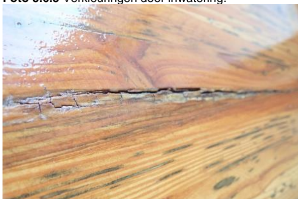
Foto 3.6.5 Barstvorming in de lamelnaad.
