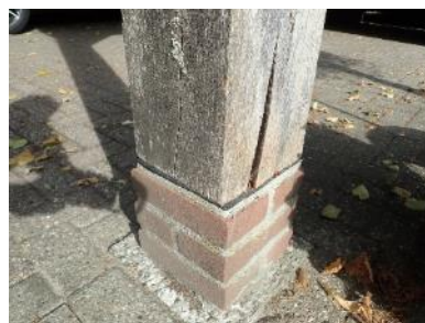
Foto 3.10.6 Aansluiting staander op stenen poer voorzijde.
