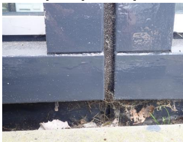
Foto 3.2.8: Aansluiting onderdorpel-stijl kozijnen met gesloten verbinding.
