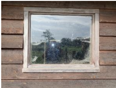
Foto 3.10.10 Zijkant (noordwest), rabat strak rond raam.
