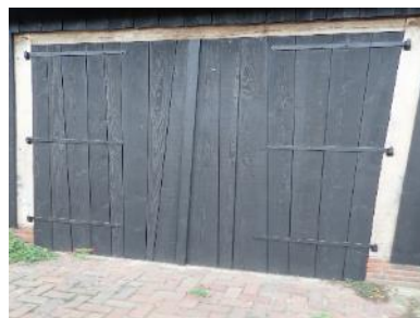
Foto 3.11.6 Grote poort aan de zijkant met scherp verschil tussen zwarte poort en verweerd eiken kozijn.
