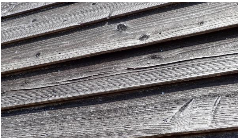
Foto 3.1.6: Afschalen van de houten delen.
