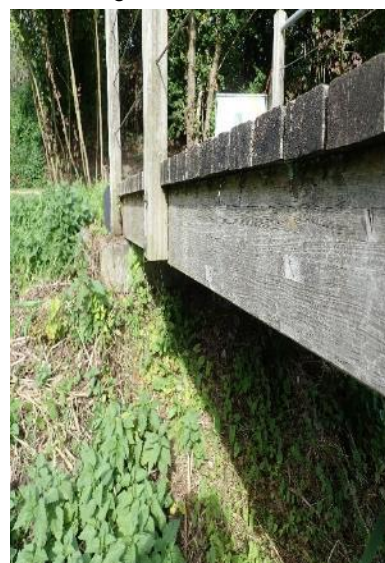
Foto 3.9.9 Dragende balken, aansluiting dek.
