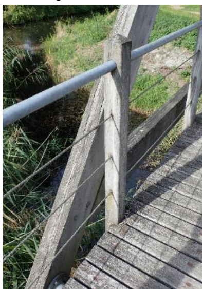
Foto 3.9.8 Draagconstructie, leuningpaal en dek.
