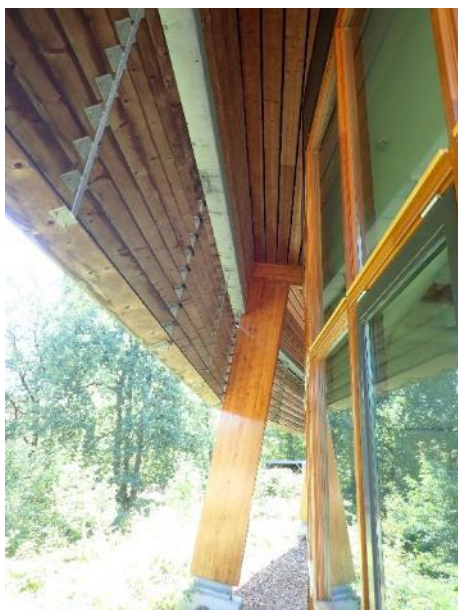
Foto 3.6.7 De kozijnen op de begane grond worden beschermd door het flinke overstek.
