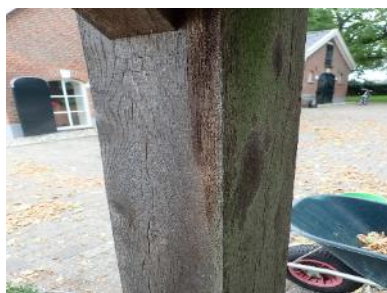
Foto 3.10.8 Staander voorzijde met insectenaantasting.
