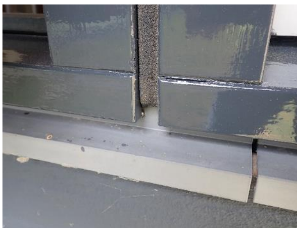
Foto 3.2.7: Aansluiting onderdorpel-stijl kozijnen met openverbinding.
