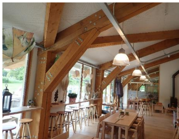
Foto 3.7.2 Binnenzijde, massieve douglas spanten.
