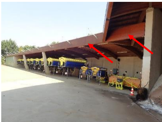
Foto 3.3.7 Verkleuring van de randbalk van Syberisch lariks.
