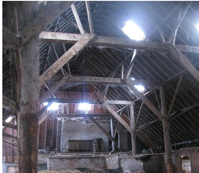
Figuur 17 – Houten portalen voorzien van schoren.
