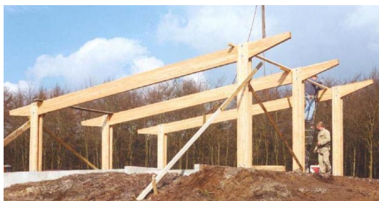
Figuur 15 – Ingeklemde portaalconstructie. [documentatie Lignostone®]
