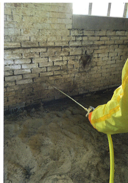
Oppervlaktebehandeling van de muur. Foto: Hoekstra Bedrijfshygiëne, Tijnje
