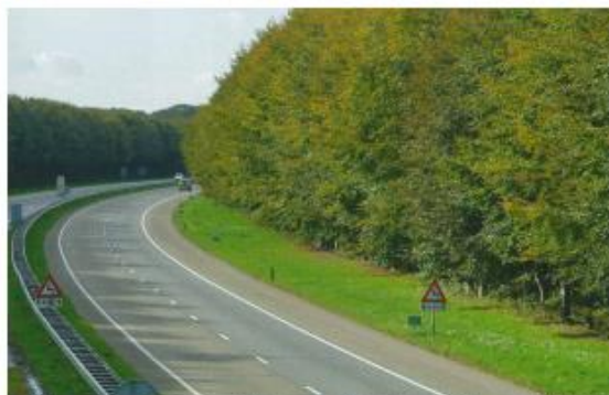
Beukenbomen langs de A18 - foto uit Rijk op Ruimtelijke Kwaliteit van Snelwegen - MUST / RWS
