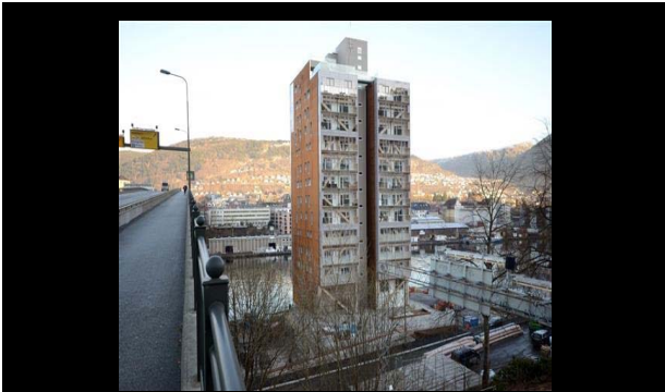
Hoogste houten ter wereld (Treet, Bergen Noorwegen): 62 appartementen, 14 verdiepingen, 50,9 m hoog (gelamineerd-houtconstructie, liftschacht, trappenhuizen, bordessen en balkons)
