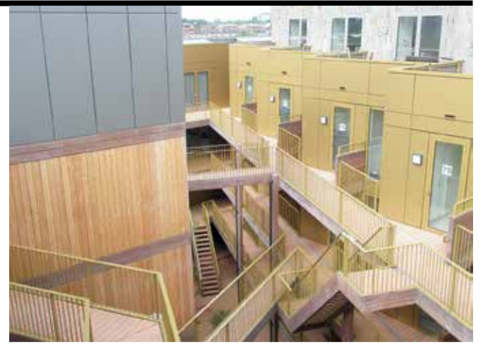
WPC dekdelen voor binnenpatio, vlonders en trappen in een woonproject.
