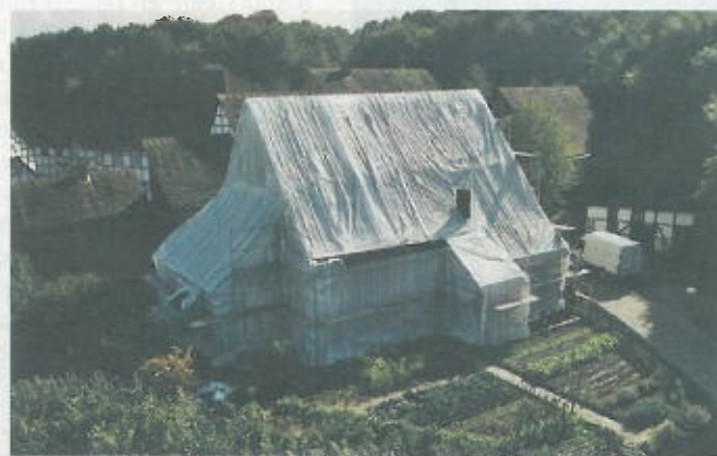
Warme-luchtbehandeling in een openluchtmuseum (foto: Thermolignum).
