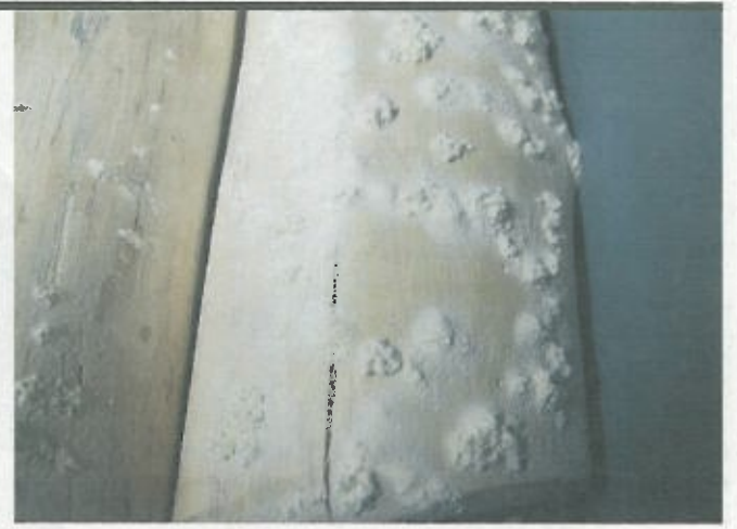
Actieve aantasting door spinhoutkever (foto: SHR).
