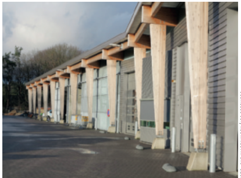
De lariks kolommen vertonen nergens schade (rot, delaminatie) ondanks een spinhoutaandeel van 5-15% aan de buitenkant.
