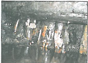
Abbildung 2 Erlenpfähle (Gitter-Fundament - roosterfundering), Oudezijds Voorburgwal, Amsterdam Foto: Fugro
