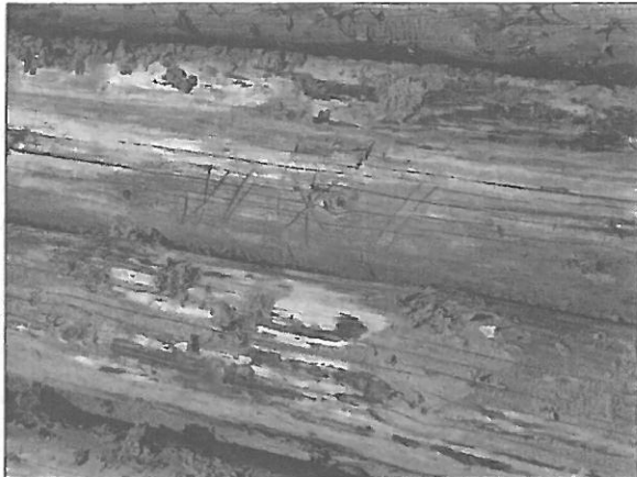
Abbildung 8 Spuren auf über 100 Jahre alten, herausgezogenen Pfahlspitzen.
