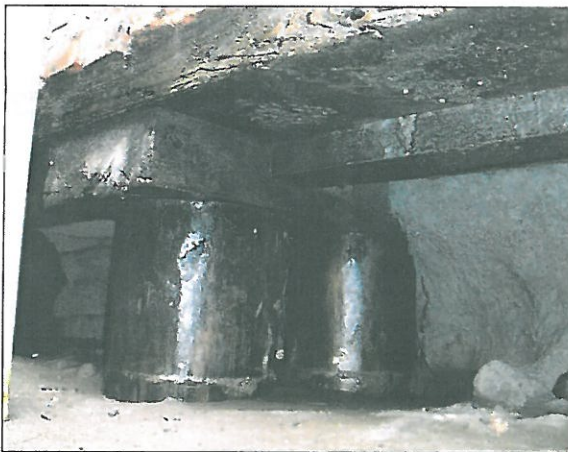
Abbildung 4 Das weit verbreitete, sogenannte Amsterdamer Fundament
