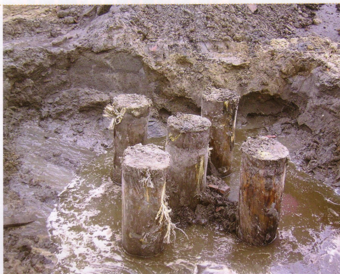
Bilderdijkstraat 50-54 in Amsterdam (2008), palen zoals ze eruit kunnen zien na jaren een gebouw te hebben gedragen.
