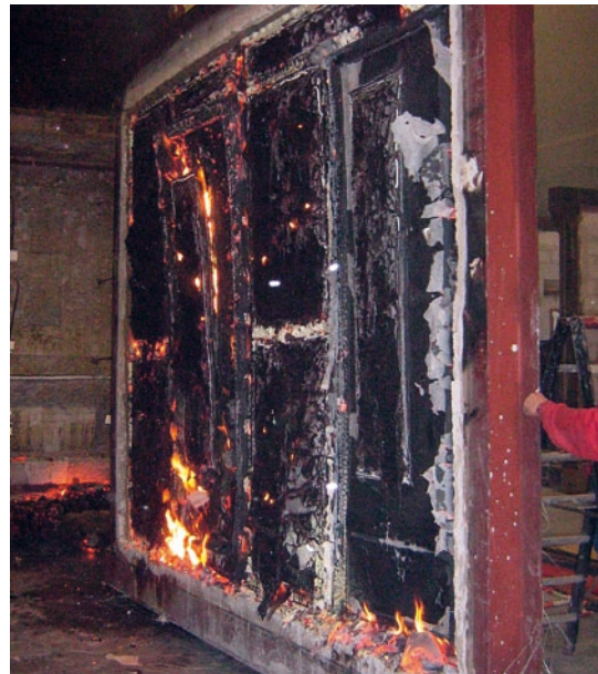
Gevelement na een brandwerendheidstest.
