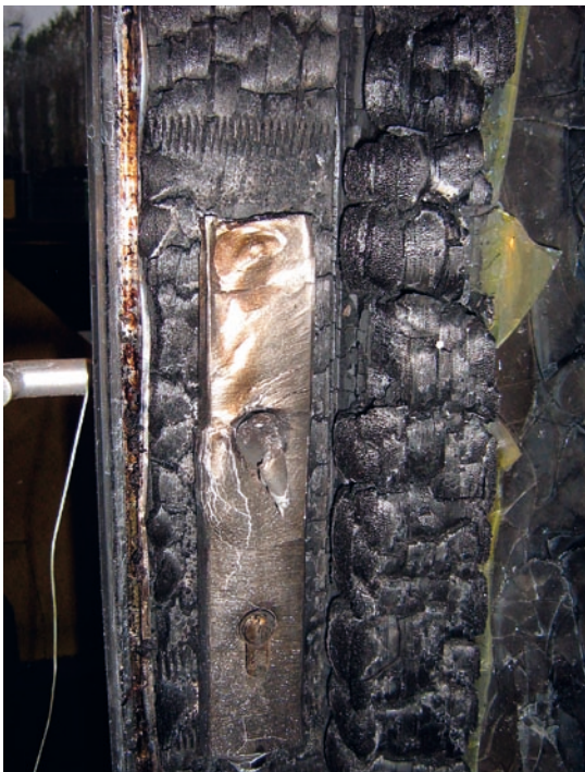
Het hang- en sluitwerk moet bij brand zo lang mogelijk op zijn plaats blijven.
