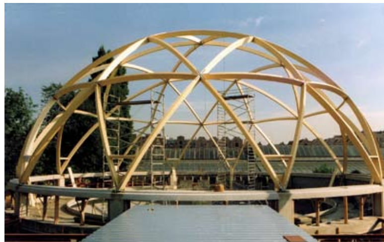
Constructie van het Planetarium in Artis (foto: Adviesbureau Lünig).
