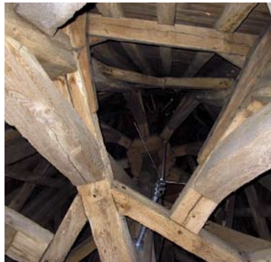
Constructie van een kerktoeren in Benshop.
