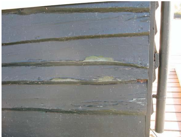
oude gevelbekleding met rot, de onderste afwerk lagen waren impregnerend terwijl de buitenste en laatst aangebrachte lagen filmvormend en meer vocht afsluitend waren
