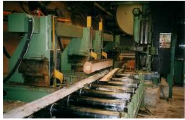
Interieur nieuwe zagerij
