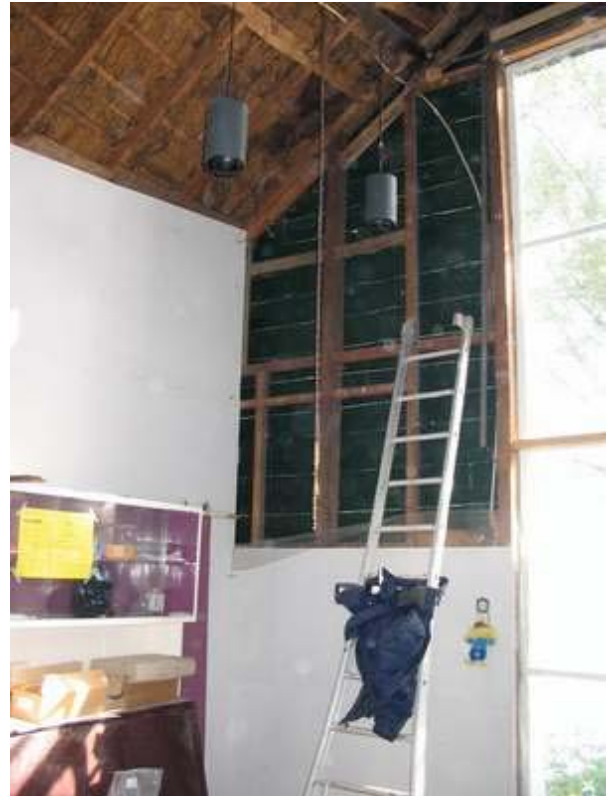
interieur braamakker, de wandopbouw is eenvoudig en niet geïsoleerd
