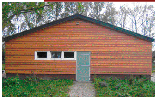
Een voorbeeld van horizontale gevelbekleding.
