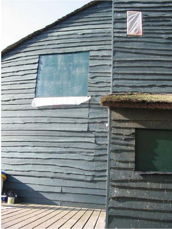
Achterzijde Braamakker voor restauratie, let op geen bies meer en wisselende schaaldeelbreedte
