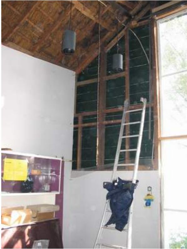
interieur braamakker, let op eenvoudige en niet geïsoleerde wand opbouw
