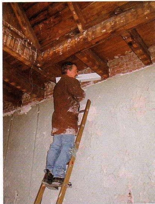
Onderzoek aan plafondbalken met Resistograaf.
